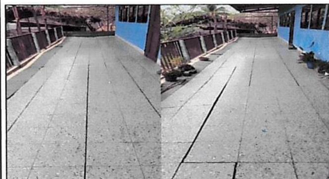
Foto 3: se quitara el piso se rellenará y apelmazara para posterior la instalación del piso nuevo de granito
